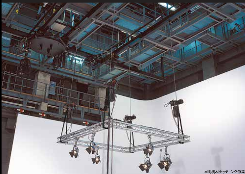
照明機材セッティング作業
