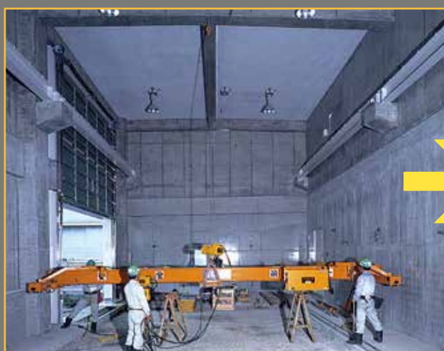
◎使用実例(1) 屋内クレーン設置作業
