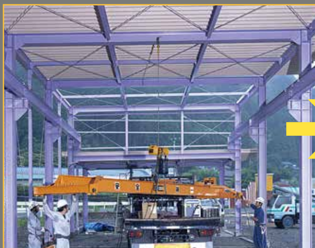
◎使用実例(2) 屋外クレーン設置作業
