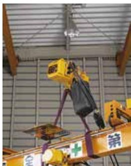
クレーン等が設置しにくい仮設現場の荷上げ作業
